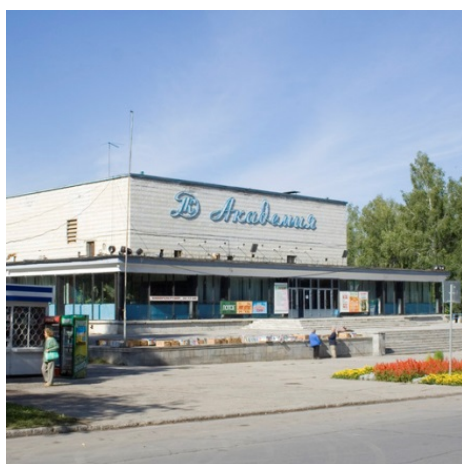
ДК «Академия» до реконструкции
