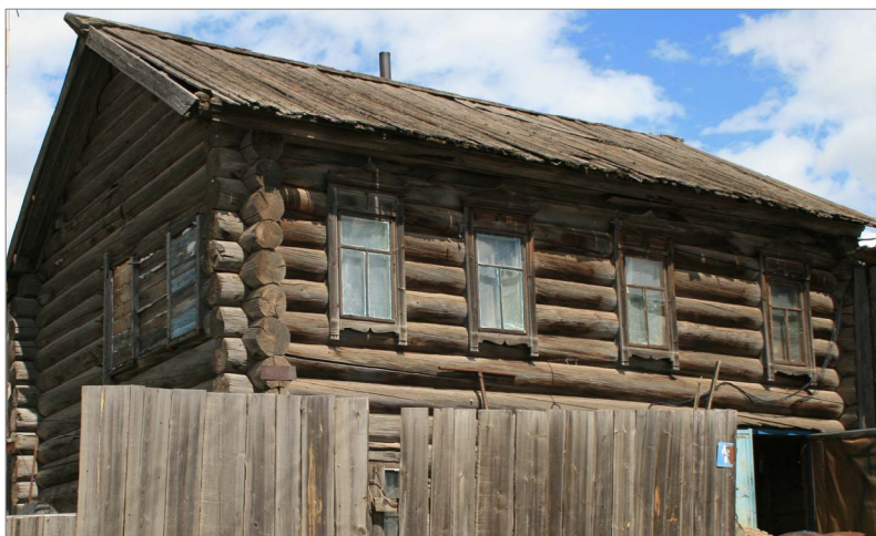
Рис. 2. Деревня Чадобец Кежемского района. Двухэтажный жилой дом. Фотография авторов. 2013 г.
