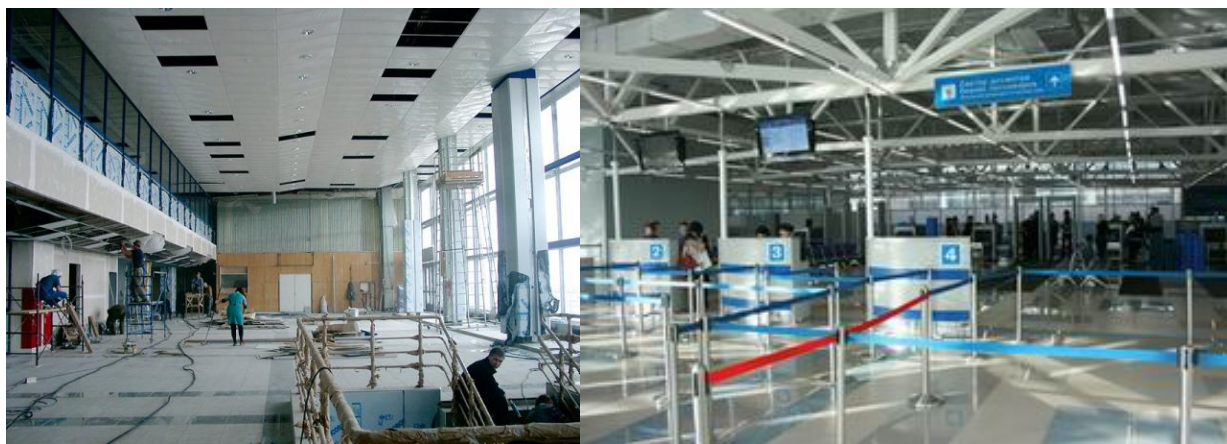
Внутренняя реконструкция аэропорта Толмачево
