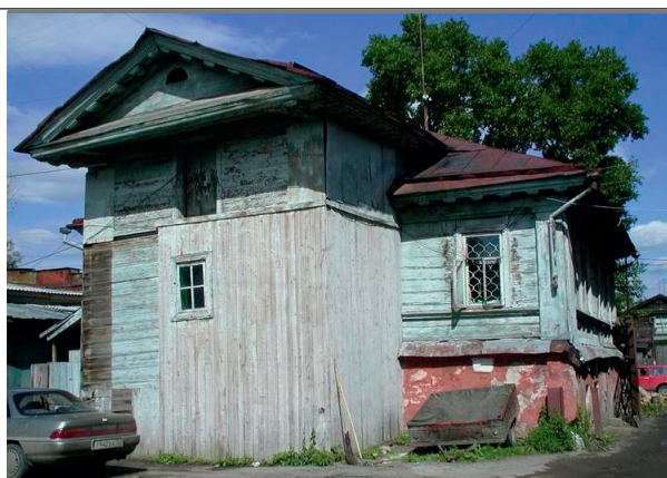
Рис. 4. Ул. Войкова, 8. Двухэтажный жилой дом на каменном первом этаже в стиле классицизм
