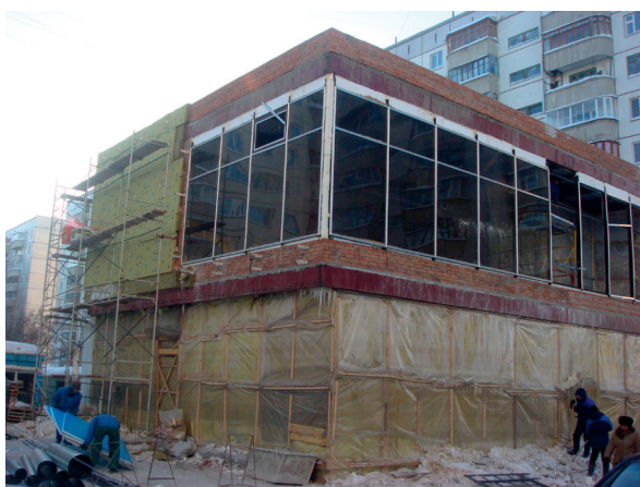
Рис. 5. Монтаж витража и утеплителя стен 2-го этажа, декабрь 2010 г.
