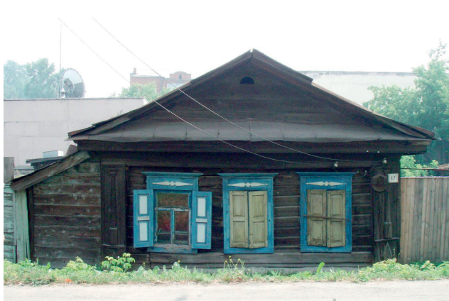
Рис. 1. Пер. Н. Островского, 17. Одноэтажный жилой дом с щипцовой крышей в три окна, с пилястрами, украшенными стилизованным ордерам
