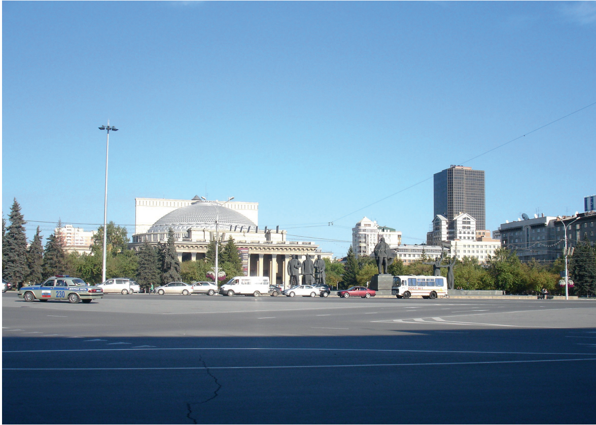
Ил. 5. Нарушение стройности архитектурного ансамбля площади Ленина в Новосибирске строительством высотного объема по ул. Депутатской
