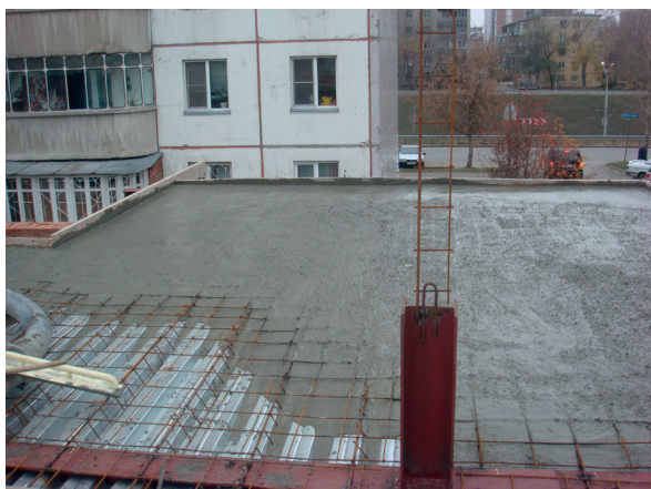
Рис. 3. Бетонирование перекрытия 1-го этажа, октябрь 2010 г.
