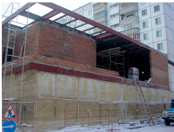
Рис. 4. Монтаж балок покрытия 2-го этажа и «теплый контур» на 1-м этаже, ноябрь 2010 г.
