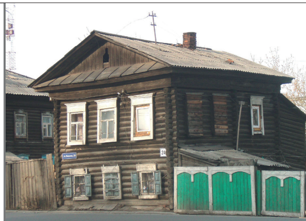
Рис. 2. Ул. Яковлева, 24. Двухэтажный жилой дом, сформировавшийся от крестьянского дома на подклете
