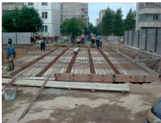
Рис. 1. Армирование перекрытия подвала под внутриквартальной дорогой, август 2010 г.
