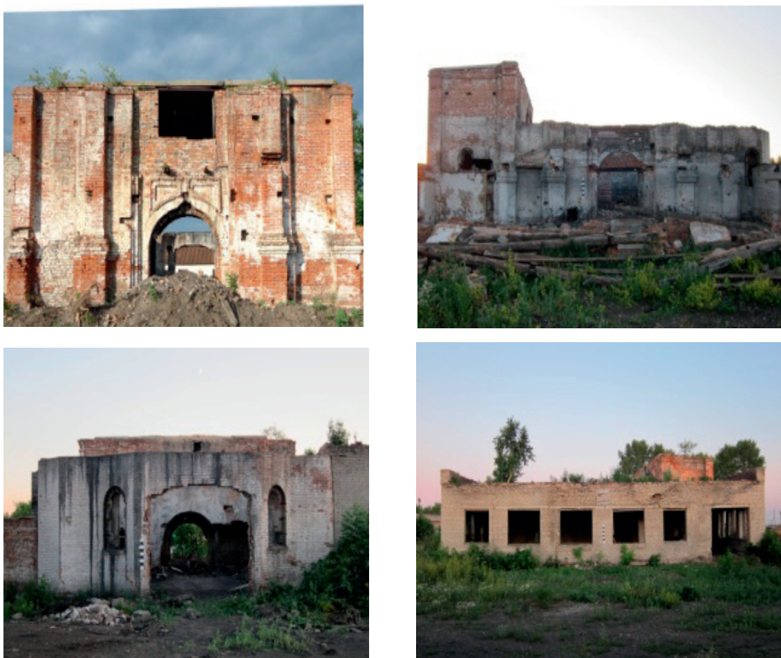
Рис. 1. Современное состояние церкви (фотографии фасадов)
