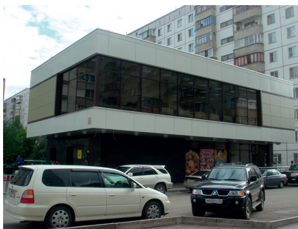
Рис. 6. Здание торгового назначения ТФ «РОСТ», июль 2011 г.
